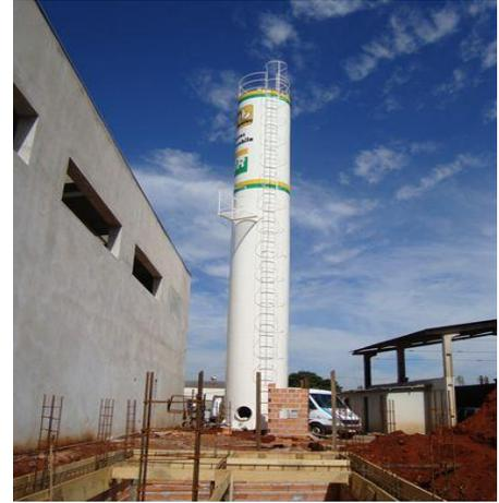
Reservatório modelo Tubular possui forma geométrica cilíndrica vertical, é fabricado em chapas de aço carbono ASTM-A36 na opção com ou sem casa de bomba. Sua capacidade esta no intervalo de 3.000 a 500.000 Litros.
