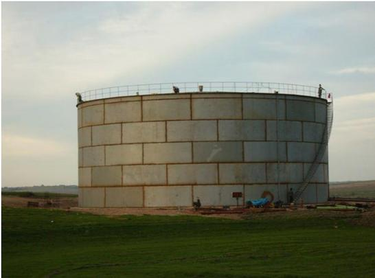
Reservatório Aéreo Vertical com fundo apoiado de 50.000 a 5.000.000 Litros construído em chapas de aço carbono ASTM-A36, com pintura interna em epóxi de espessura mínima de 250 microns e revestimento externo em esmalte sintético ou poliuretano de espessura mínima de 200 microns.
