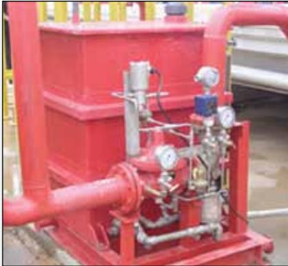
O DIFFS utiliza a Válvula Automática para Controle de Dilúvio Cla-Val Modelo 134-60 para liberar rapidamente espuma ou água, extinguindo chamas em menos de 15 segundos.
