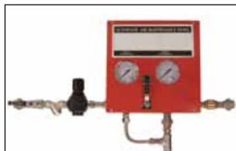
O painel de manutenção automática de ar mantém automaticamente a pressão do ar ou do nitrogênio nos limites pré-estabelecidos em um sistema de sprinklers de tubulação seca ou uma linha piloto seca que atua no sistema de dilúvio ou de pré-acionamento.
