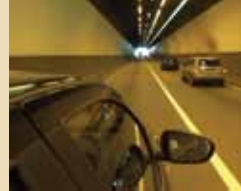
Túneis ferroviários e rodoviários
