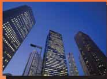
prédios altos comerciais
