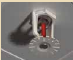
Sistema de sprinklers de alta pressão
