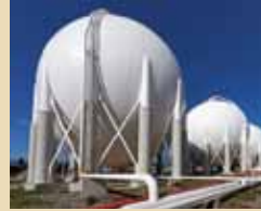
Armazenamento de substâncias químicas e materiais inflamáveis
